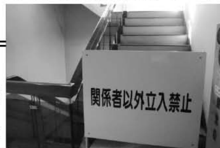
▲議会のある西庁舎の一部階段が使用禁止に。
