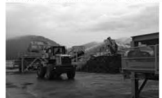
災害廃棄物選別処理施設（女川町）
